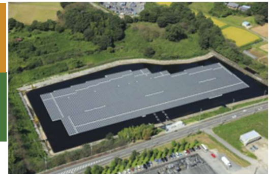
嵐山水上太陽光発電所
